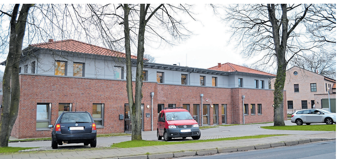
So sieht die Kindertagesstätte in Heidenau jetzt aus Foto: bim
