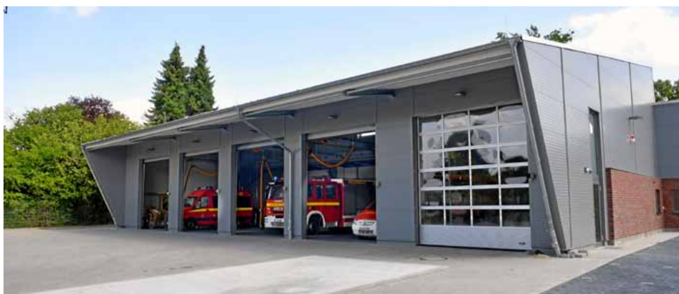
Das neue Feuerwehrhaus an der Dorfstraße 201 bietet der Feuerwehr ausreichend Platz.
