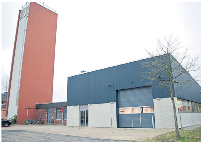
Auf rund zwei Millionen Euro belaufen sich die Baukosten für die neue Feuertechnische Zentrale an der Harburger Straße in Soltau.
